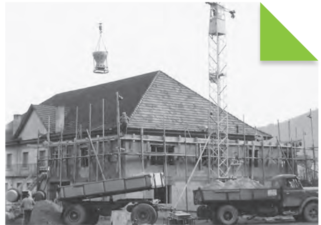
Bau des Hallenanbaus
